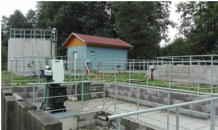
Dokončená čistírna odpadních vod
